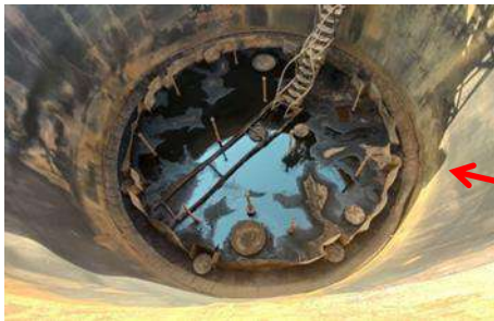
شکل ۳- وضعیت سقف شناور پس از آتش سوزی
