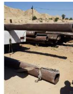
نحوه استفاده از تسمه یک متری با دو قلاب، جهت باربرداری دو لوله به طور همزمان
