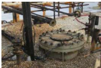
شکل ۴- فلنج محل نصب پمپ عمودی
