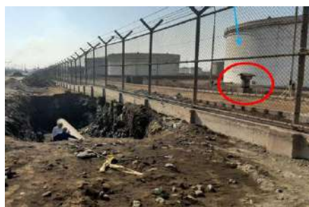
شکل ۱- نصب ترانس در فاصله ۱۰ متری خط
