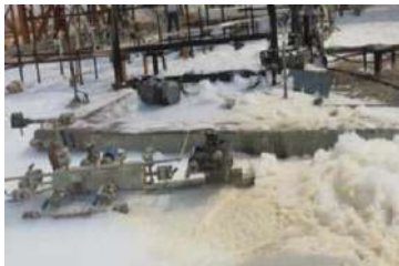
شکل ۲- ظرف Closed Drain مدفون
