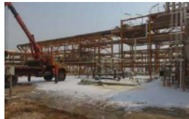
شکل ۱- محل استقرار کفی جرثقیل مجاور سامپ ظرف Closed Drain
