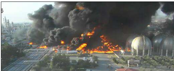
شکل ۲- گسترش آتش به محوطه اطراف مخازن
