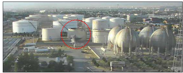
شکل ۱- بروز نشستی اولیه در مخزن
